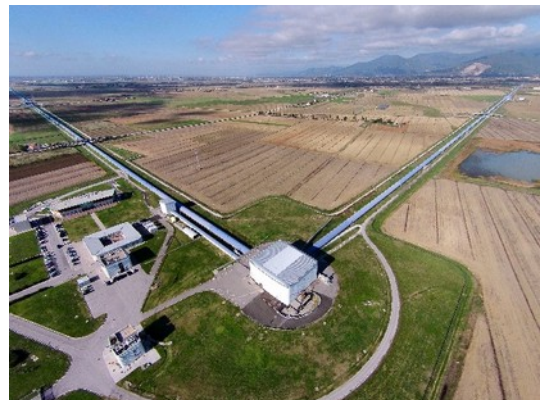
Widok z lotu ptaka detektora fal grawitacyjnych Advanced Virgo, położonego w Cascinie obok Pizy (Włochy). Advanced Virgo jest gigantycznym interferometrem laserowym o ramionach długości 3 km (Nicola Baldocchi / The Virgo collaboration).
